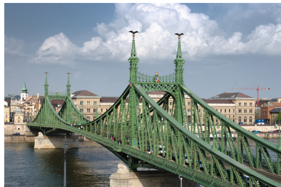
A képeken a Kőröshegyi völgyhíd és a budapesti Szabadság híd láthatjuk. Előbbi esetén alátámasztások sora, utóbbi esetén is négy alátámasztási pont látható.
