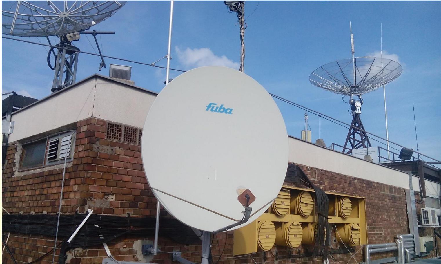
E-épület tetején telepített antennák
